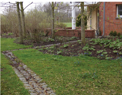
Figur 2: Regnvand ledes i en rende bort fra huset til nedsivning i græsplænen eller i et regnbed. Trabrennbahn Farmsen, Hamburg. Foto Orbicon.
